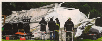
Unverletzte Orkanbänen rissen am 18. August 2017 das Festzelt in Frauchereck (St. Johann am Walde) weg. Rechts der zerstörte Vorbau. (Foto: J. W. / PHOTOWIRE)
